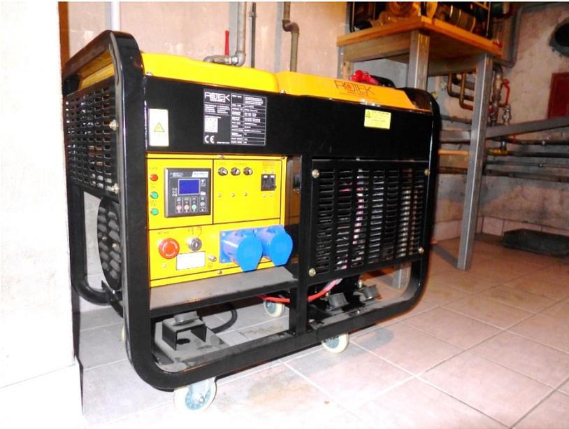
Abbildung 20: Stromerzeuger 1-phasig Rotek 14kVA im Kellerraum. (Quelle: SCHNEEFLOCK 2018)
