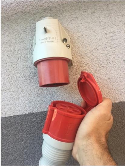
Abbildung 15: Einspeisedose an der Hauswand. (Quelle: FEUERWEHR OLLERN 2018)
