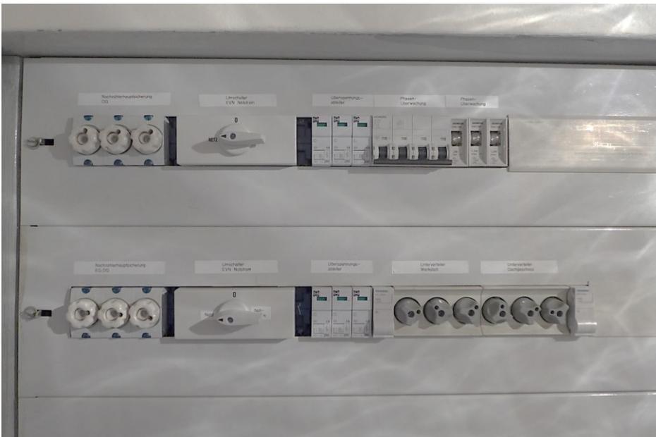
Abbildung 21: Netzumschalter im Spannungsverteiler für Obergeschoss und Erdgeschoss. (Quelle: SCHNEEFLOCK 2018)
