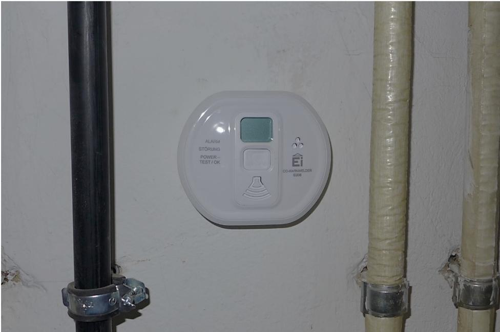
Abbildung 24: Kohlenmonoxid Warner im Aufstellraum des Stromerzeugers. (Quelle: SCHNEEFLOCK 2018)
