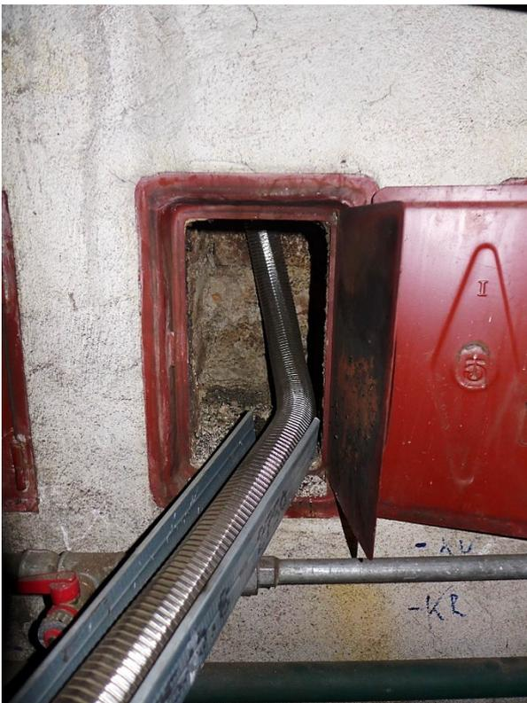
Abbildung 23: Abgasführung mit Abgasschlauch in den freien Kamin. (Quelle: SCHNEEFLOCK 2018)
