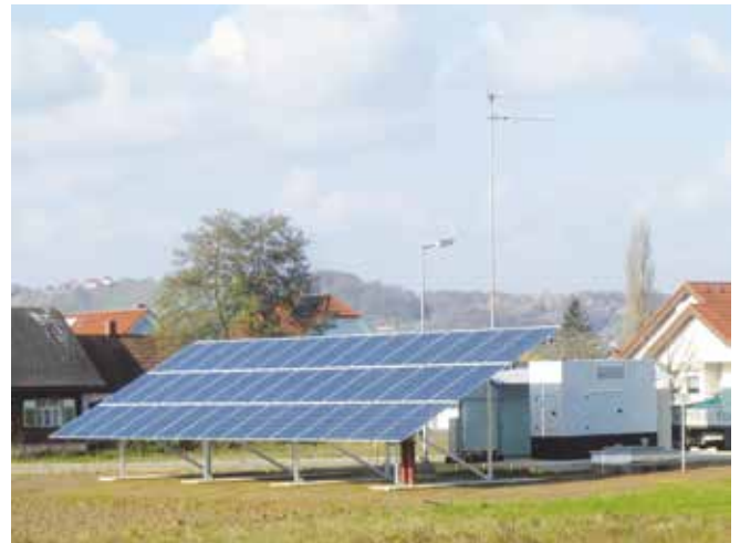
Wasserpumpwerk Hof bei Straden.
